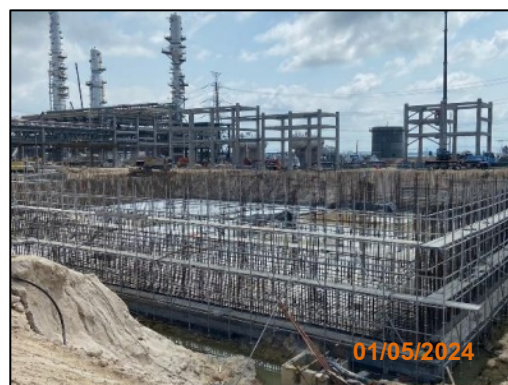
งานโครงสร้างถังรวบรวมน้ำทิ้งของโครงการ
