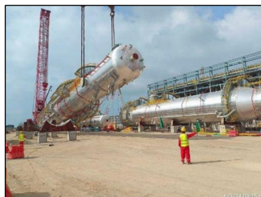
งานติดตั้งหอกัน (Gas Column Installation)
