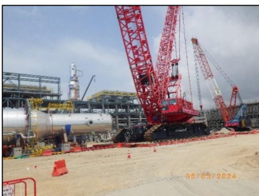
งานติดตั้งหอกัน (Gas Column Installation)
