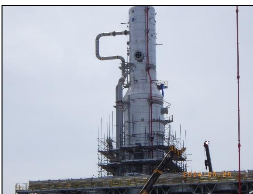
งานติดตั้งหอกลั่น (Gas Column Installation)
