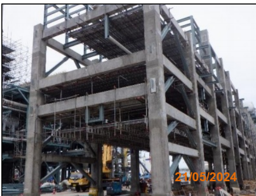
งานโครงสร้างชั้นวางท่อ (Pipe-Rack)
